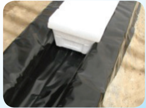
شكل رقم (١٧): يوضح استخدام البلاستيك الأسود لتغطية القنوات
