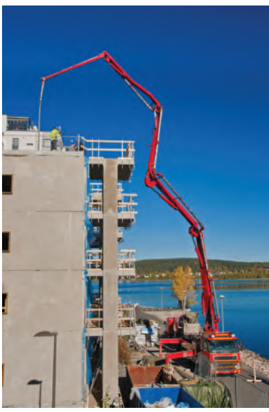
الشكل ٢٠ تستعمل بعض المعدات الهيدروليكية في أعمال البناء.
