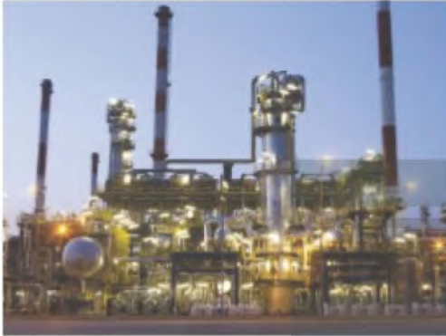
محطة توليد الكهرباء في الجبيل
