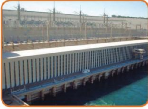
محطة السد العالي لتوليد الكهرباء
