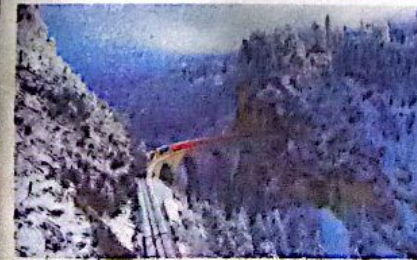
طريق سكة حديد داخل ممرات جبلية
