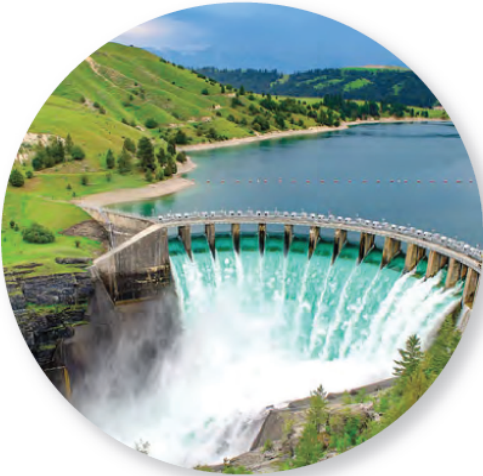
الشكل (9) بناء السدود
